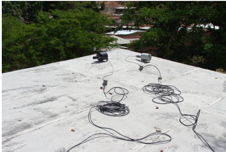
Figura 5.2. 96.- Sensores Ch 1 y Ch 2.
