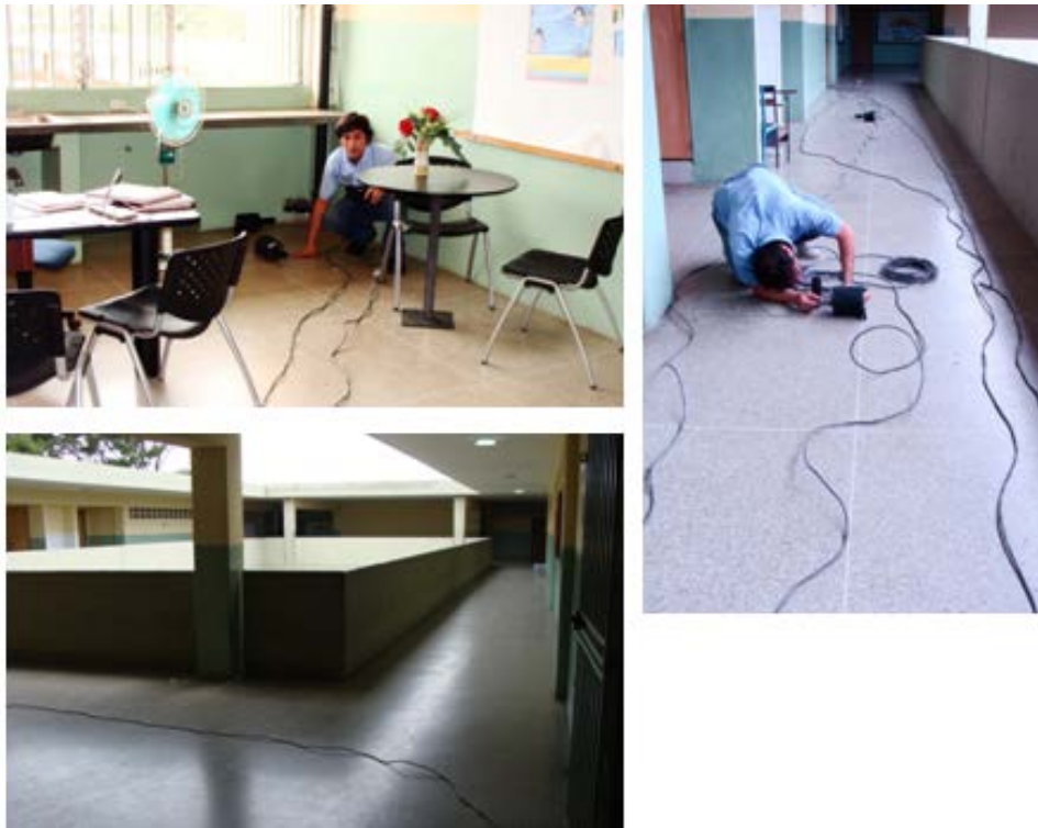
Figura 5.2. 64.- Instalación de sensores Ch 5 y Ch 6 (arriba), sensores Ch3 y Ch4 (derecha) y vista interior del plantel (abajo).
