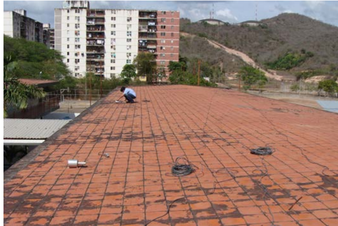
Figura 5.2. 52.- Instalación de los sensores Ch 3 y Ch 4
