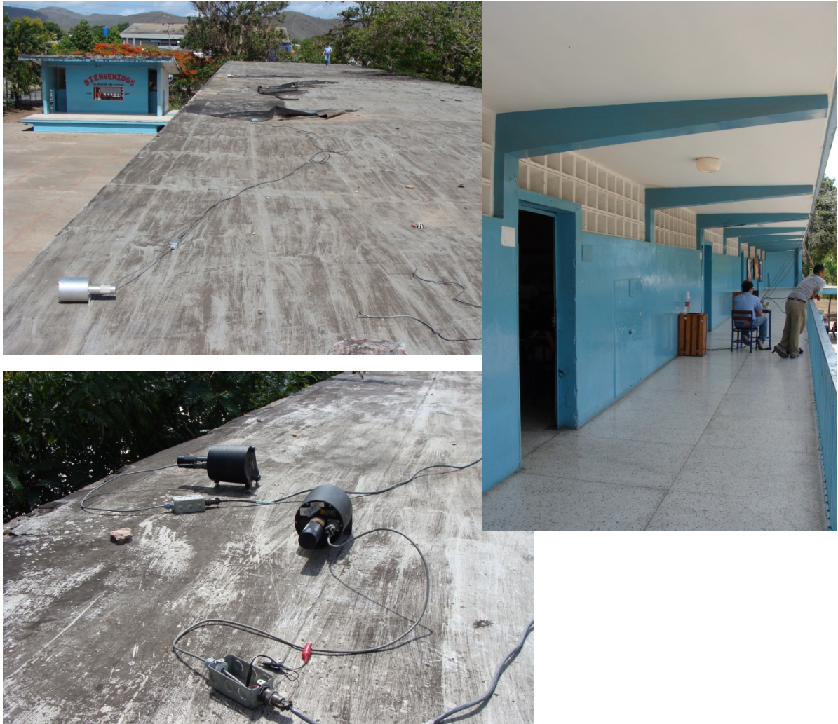
Figura 5.2. 77.- Sensores Ch 5 y Ch 6 (inferior), vista de la losa de techo (superior), Vista desde el segundo nivel (derecha).
